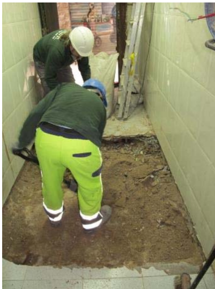
Foto 4: Tasques d'excavació de la preparació del paviment UE 2
