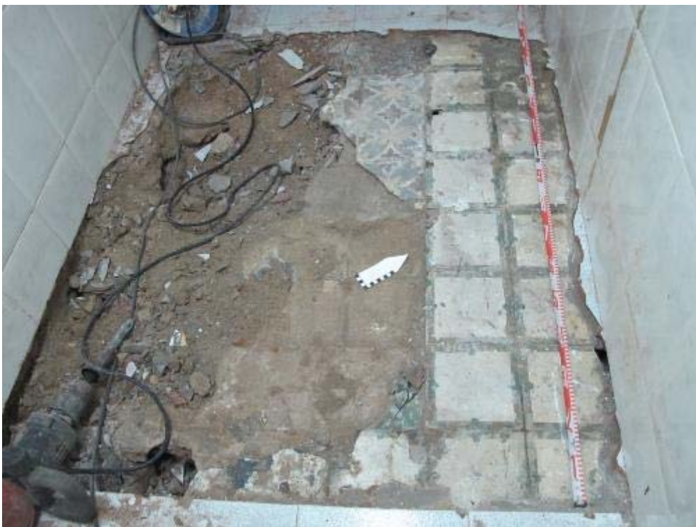
Foto 3: Restes del paviment UE 2 després de l'extracció del paviment actual UE 1
