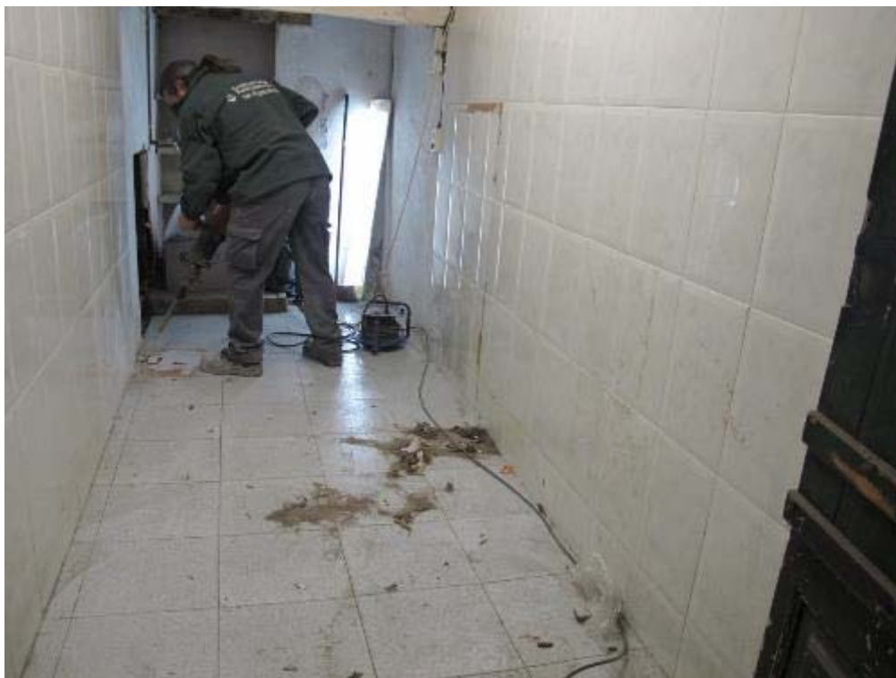
Foto 2: Inici de l'excavació
